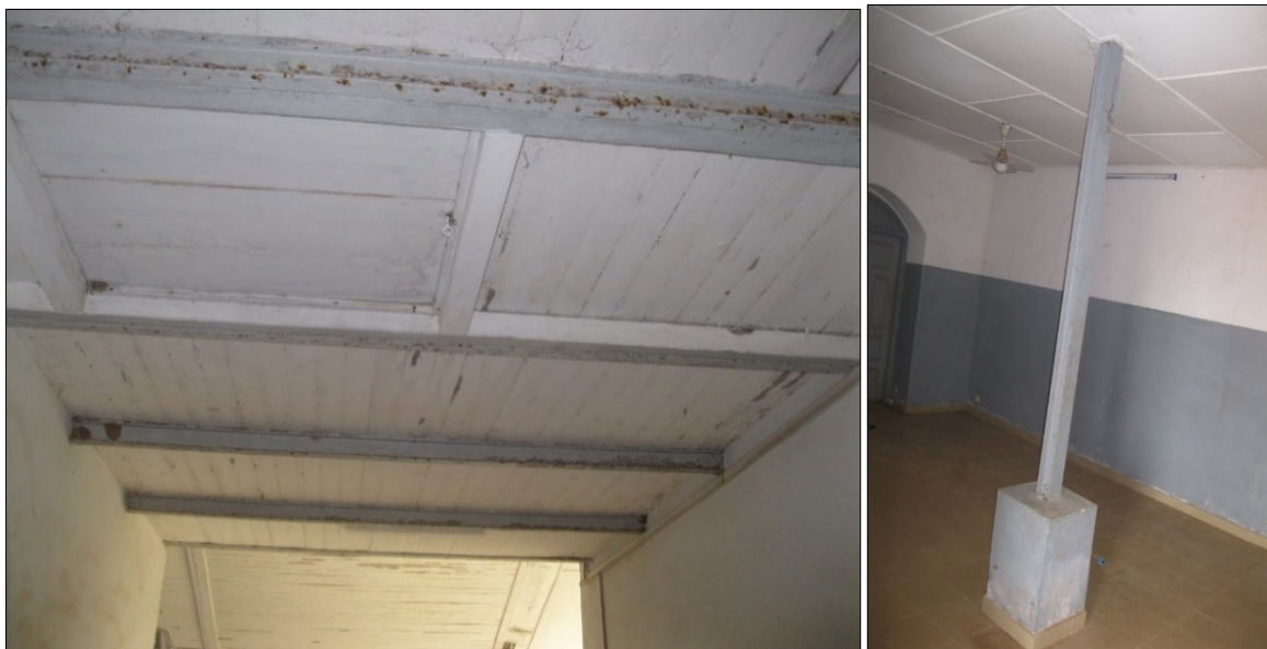
Photo 6 et 7 : Présence de l'acier dans l'édifice
