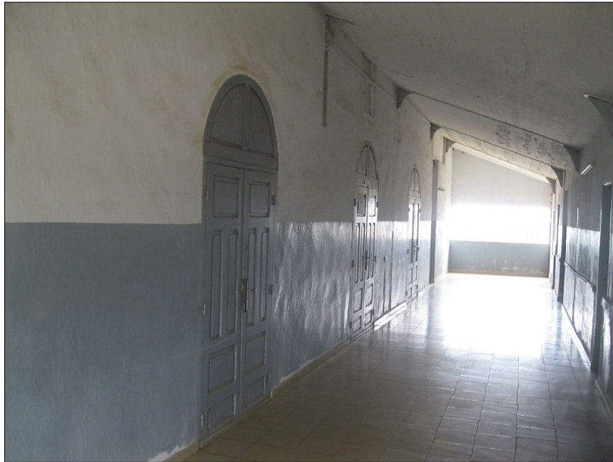
Photo 5 : Vue de couloirs et portes internes
