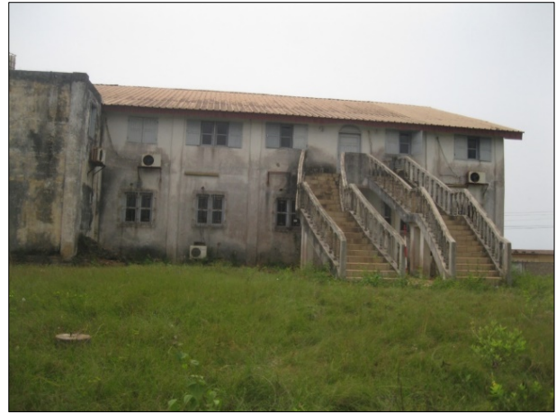
Photo 2 : État actuel de la façade ouest
