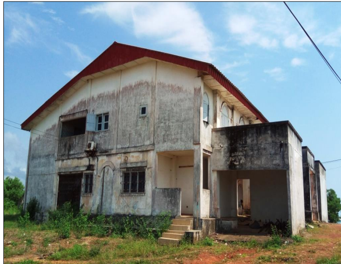
Photo 3 : Vue générale du bâtiment
