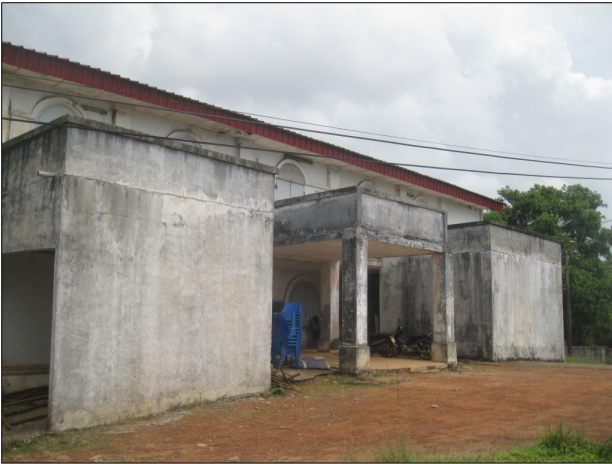
Photo 1 : État actuel de la façade nord
