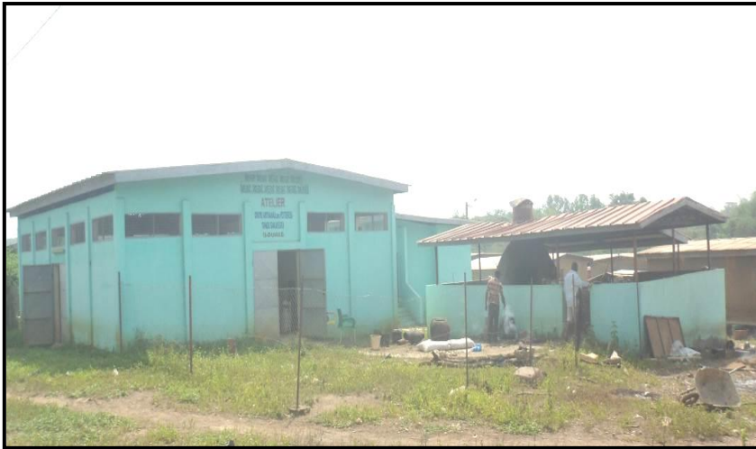
Photo n°1 : Centre artisanal reconstruit à Tanou-sakassou
