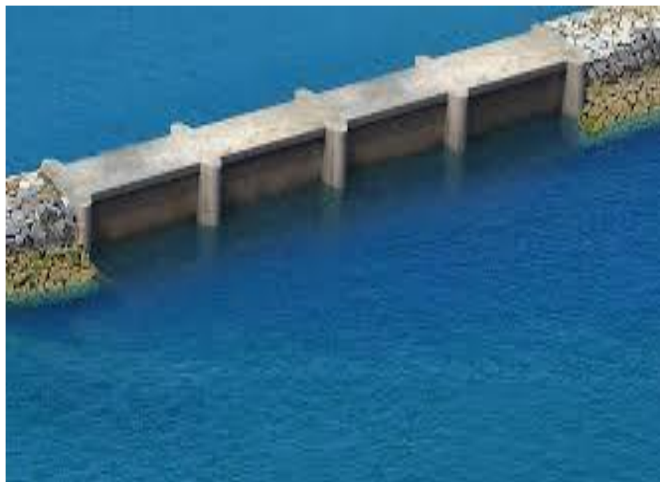
Photos: Des digues
