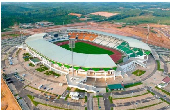
Image n°1 : Stade Laurent Pokou construit à San Pedro en prélude à la CAN 2023
