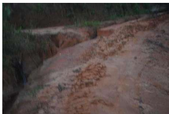
Photo 2 : Voie d'accès au site Agropastoral « Campement Ambassadeur » fortement dégradée Sources : BISSOU (2016)
